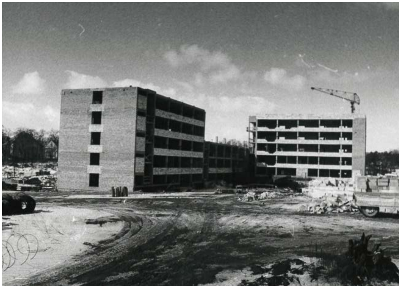
Wydział Technologii Drewna w budowie
