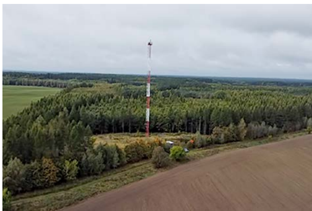
Zdjęcie przedstawia jedną z dostrzegalni przeciwpożarowych (maszt). Detektory zawieszone są na trzech wysokościach: 1) 3 m; 2) 24 m; 3) 48 m.
