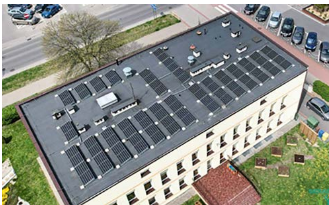
Rys. 1. Mikroinstalacja fotowoltaiczna na budynkach użyteczności publicznej w Sieradzu
